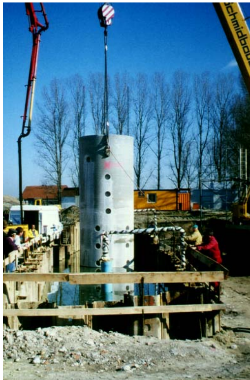
ABBILDUNG 1: DER ZENTRALBRUNNEN ZUR ERFASSUNG DES HEBESCHACHTES WIRD EINGEBRACHT
